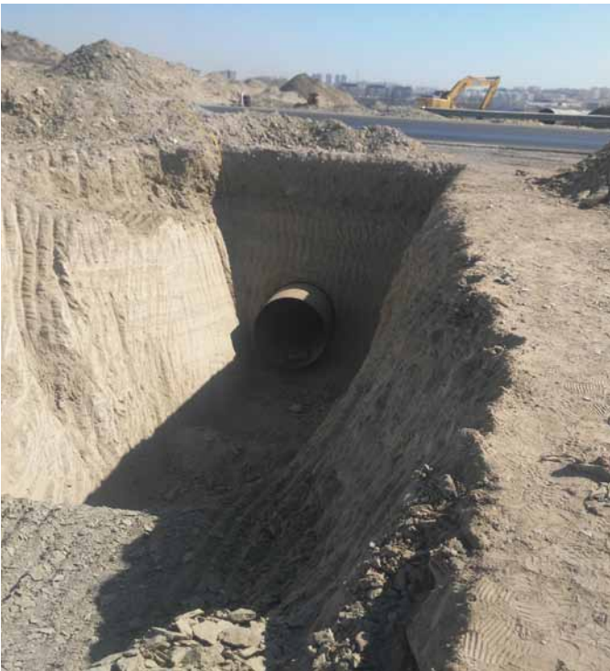
چاله دریافت پایپ جک در جاده برگشت بندر سیرجان- 1400 Pipe Line- 15+810 KM
