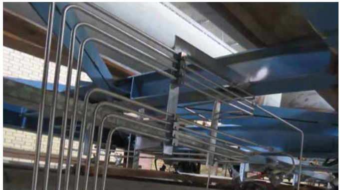
لوله‌کشی و نصب قطعات برق و ابزار دقیق بخار واحد ۱
