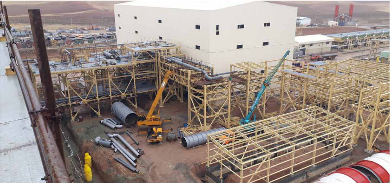
اجرای پایپینگ بخش بخار
