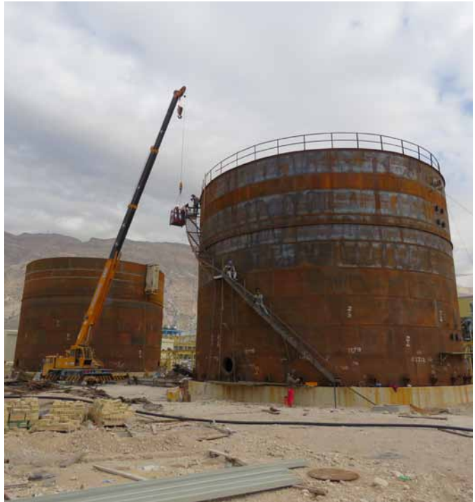
اجرای مخازن آب شیرین کن
