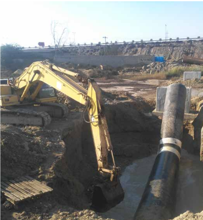
انجام عملیات اجرایی در کریدور آب شور ۱- 1400 Pipe Line- 00+300 KM
