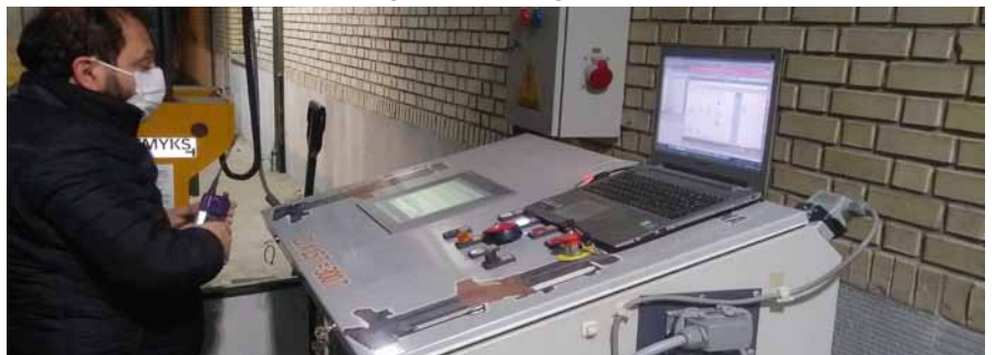
نصب و راه‌اندازی جک‌های سنکرون بالا بر قطار
