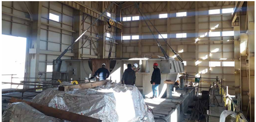
نصب کیسینگ بخش کم فشار توربین بخار
