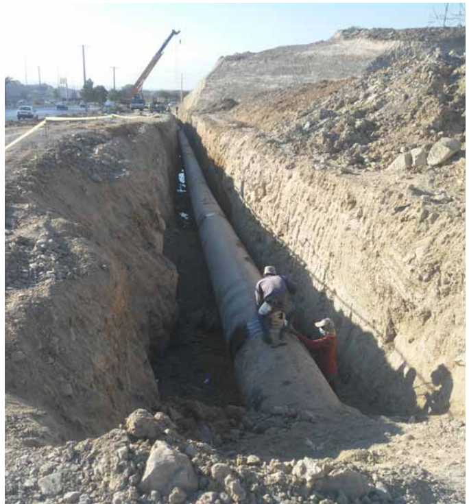
انجام عملیات اجرایی در محدوده این کات شهید رجایی 1200 Pipe Line- 27 KM
