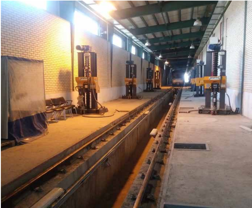
نصب و راه‌اندازی جک‌های سنکرون بالا بر قطار
