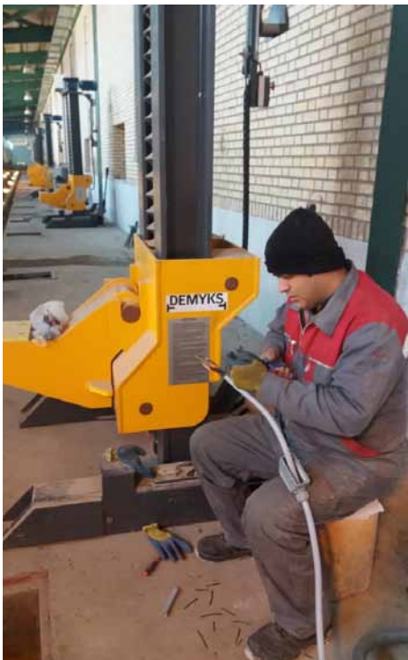
نصب و راه‌اندازی جک‌های سنکرون بالا بر قطار
