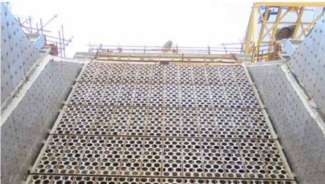
صفحات نصب شده اینلت داکت بویلر باز یافت واحد ۳
