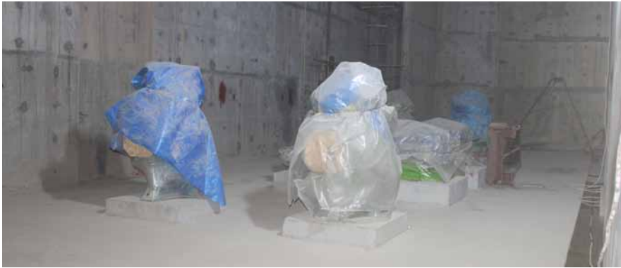
نصب تجهیزات سیستم کولینگ در طبقه اسپیرال کیس
