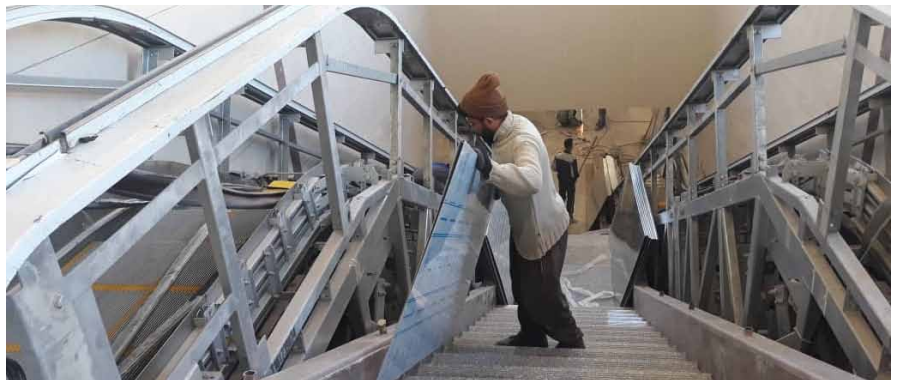
نصب پله برقی‌های ایستگاه کوهسنگی و کاوه
