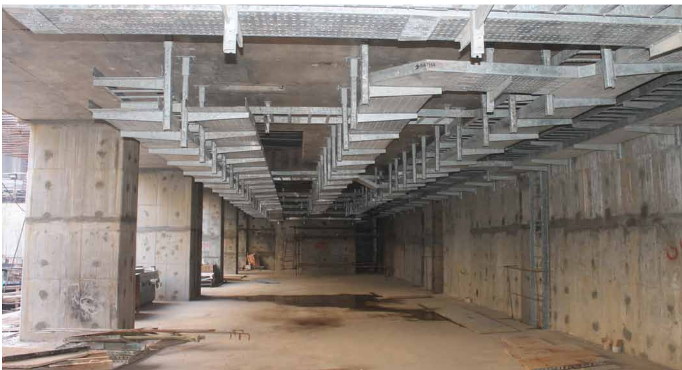
نصب سینی و نردبان کابل در طبقه ژنراتور
