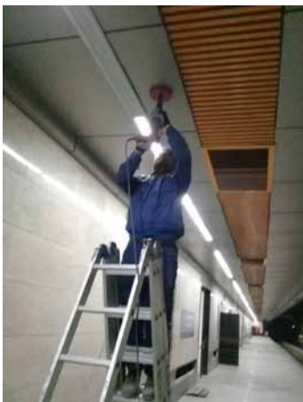
ایستگاه مولاتی - نصب اسپیکر
