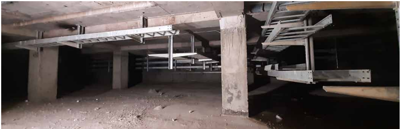
نصب نردبان کابل سیستمک تهویه و گالری کابل RS ایستگاه اندشت
