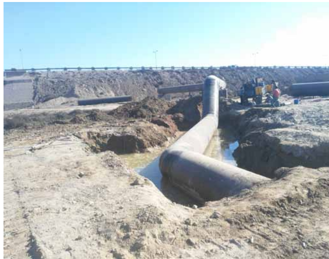
انجام عملیات لوله‌گذاری در محدوده پل پالایشگاه- 1400 Pipe Line- 00+135 KM
