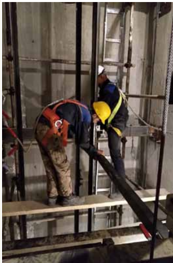
ایستگاه کمیل - وضعیت نصب آسانسور
