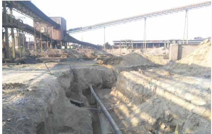
- تخریب دیوار و آماده‌سازی جهت عبور از لوله پلی اتیلن- 1400 Pipe Line- 01+900 KM
