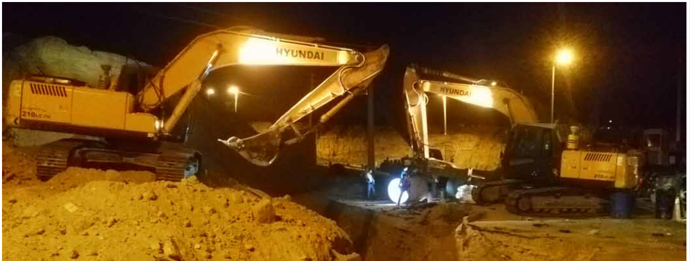
انجام عملیات حفاری در بلوار امام حسین- 1200 Pipe Line- 28+000 KM
