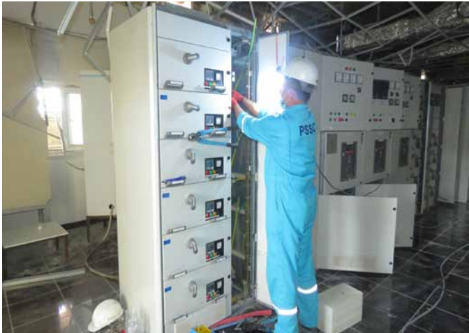
نصب گلند و کانکشن تابلوهای سوئیچگیر ACC واحد دوم
