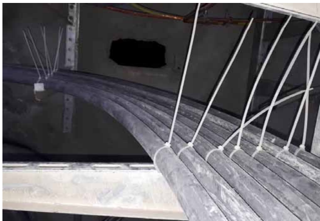
ایستگاه رودکی - نصب کابل هواساز ایستگاه رودکی
