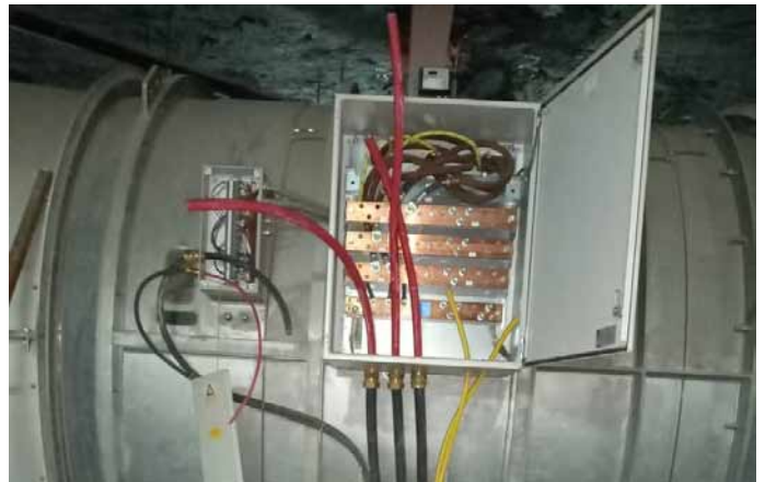
کابل کشی کابل مربوط به فن
