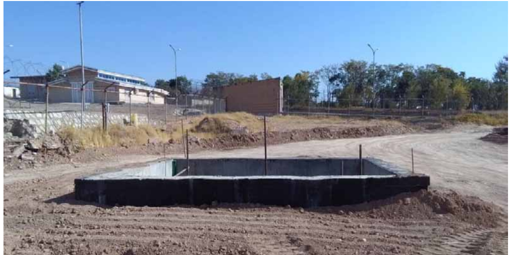
ساخت پیت مخزن دفنی درین و بکفیل آن
