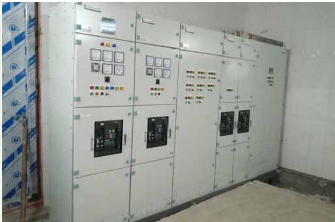
ایستگاه صنعت - نصب سل تابلو مربوط به هواساز
