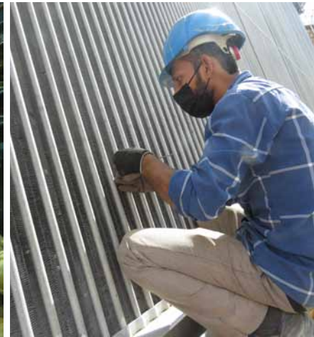
تمیز کاری و شانه کشی تیوب بندل های ACC واحد یک
