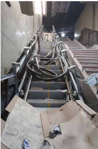
انتقال و نصب پله برقی‌های ایستگاه سعدی
