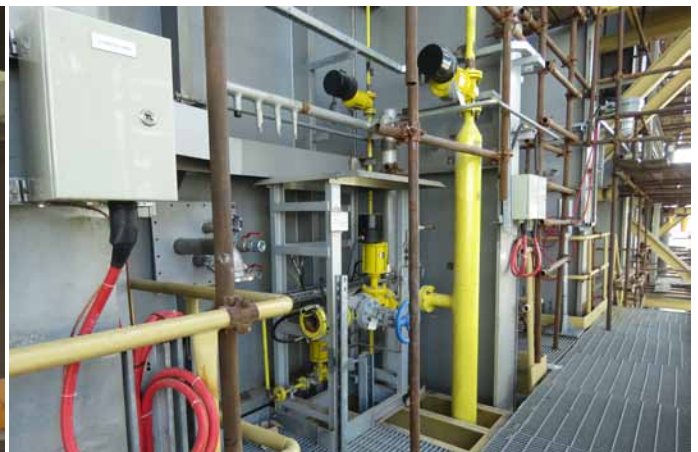
نصب جانکشن باکس های HRSR واحد سوم
