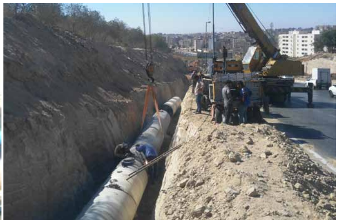
انجام عملیات لوله‌گذاری در بلوار امام حسین- 1200 Pipe Line- 28+000 KM
