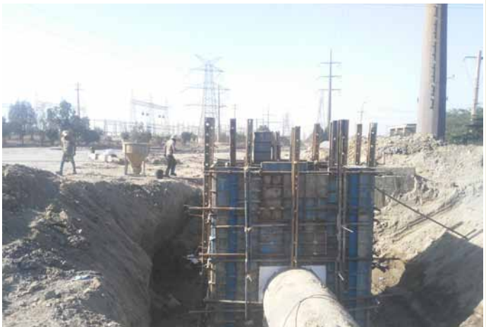
انجام عملیات سیویل حوضچه- 1400 Pipe Line- 01+850 KM
