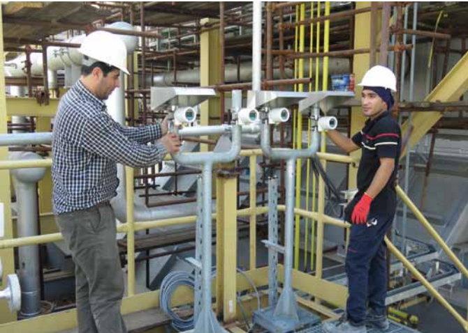
نصب تجهیزات ابزار دقیق HRSG واحد سوم
