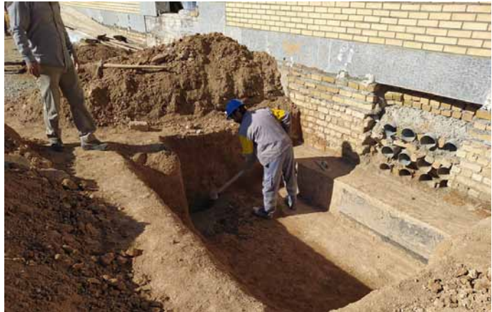
حفاری منهول الكتريكال پست برق
