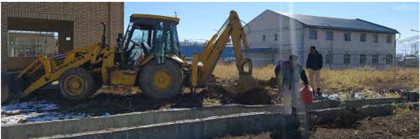
اجرای داکت بانك‌هاي الكتريكال، ابزار دقيق و تلکام
