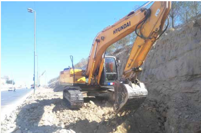
انجام عملیات حفاری در بلوار امام حسین- 1200 Pipe Line- 28+000 KM
