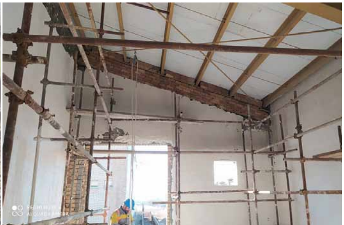
فعالیت‌های معماری ساختمان کنترل پست برق
