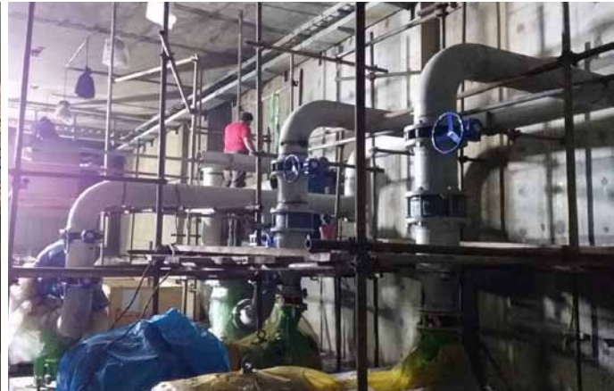
اجرای پایپینگ کمکی در نیروگاه
