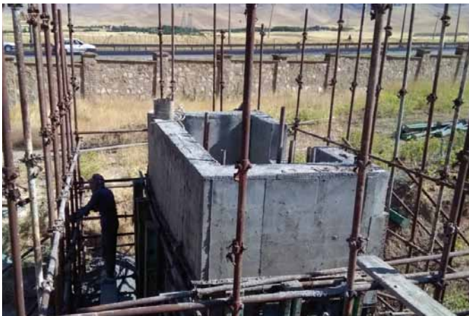
اجرای منهول آب‌های سطحی
