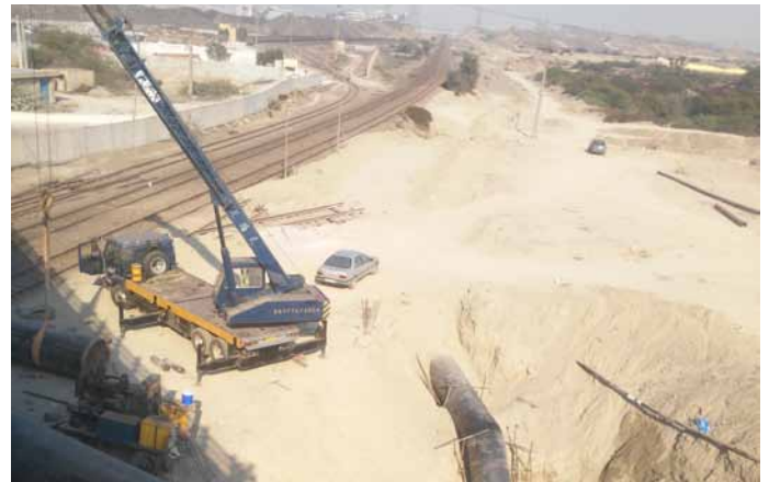
انجام عملیات لوله‌گذاری در ضلع شرقی پل توسعه- 1400 Pipe Line- 03+200 KM
