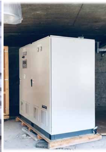
نصب پنل ها در نیروگاه
