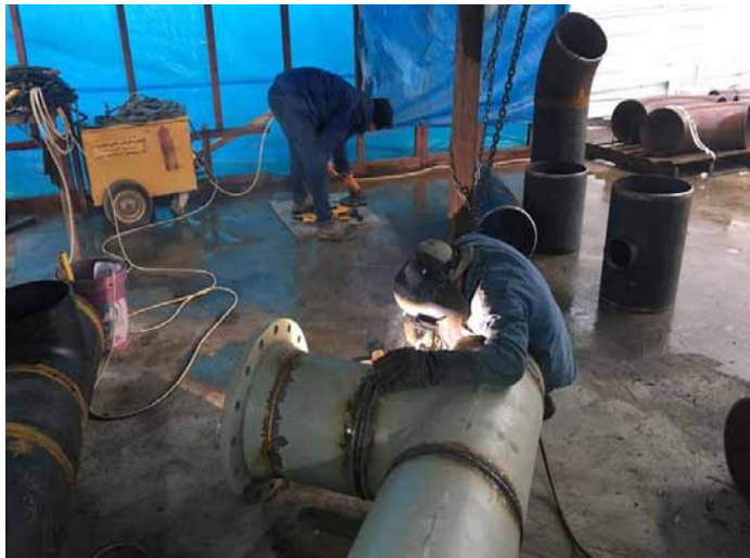
ساخت اسپول‌های لوله در نیروگاه
