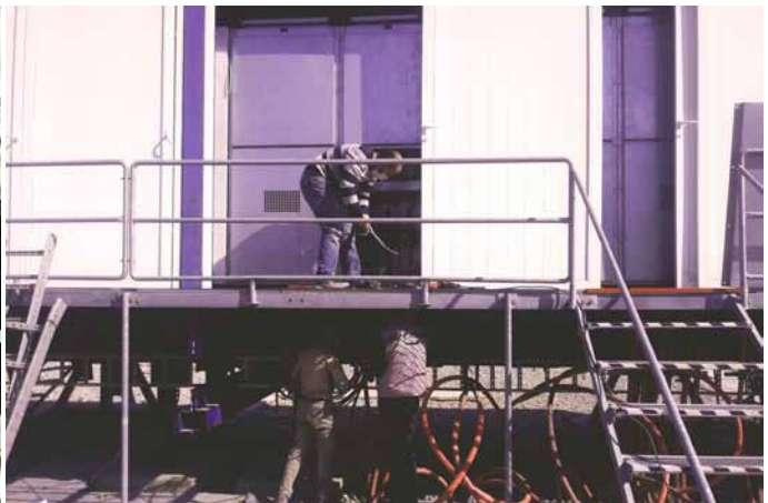
نصب نردبان کابل سیستمک تهویه و گالری کابل RS ایستگاه اندشت
