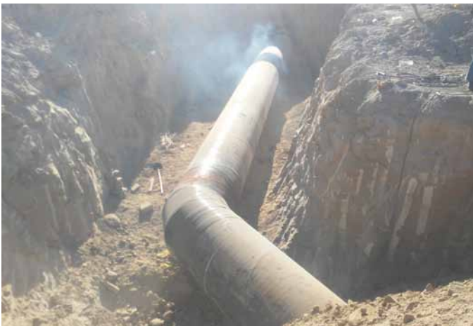
انجام عملیات لوله‌گذاری در بلوار امام حسین- 1200 Pipe Line- 28+000 KM
