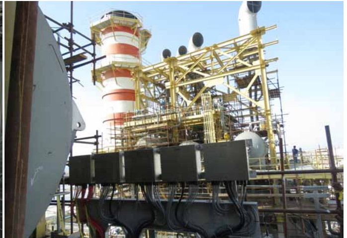
نصب جانکشن باکس های HRSR واحد سوم
