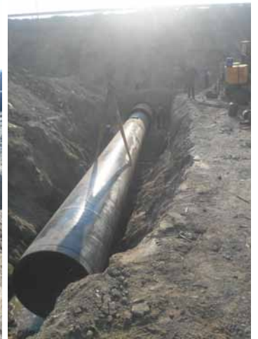
انجام عملیات لوله‌رانی در پل پالایشگاه 1400 Pipe Line- 00+150 KM-
