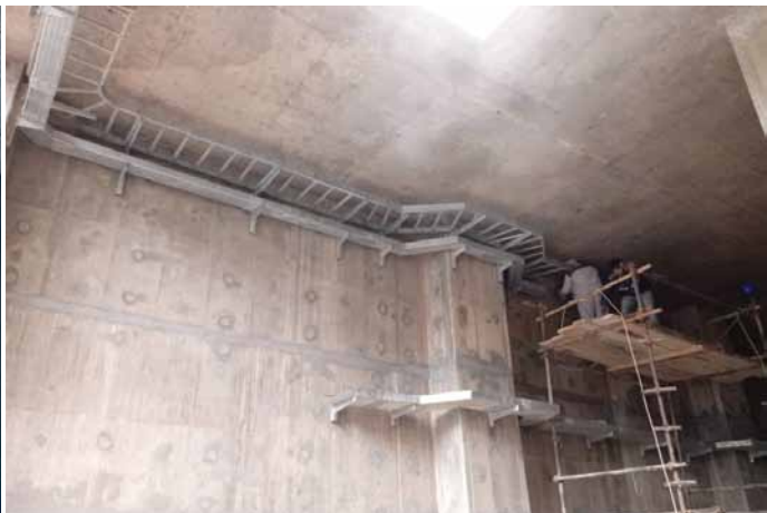
نمایی از اجرای سینی و لدر در طبقات نیروگاه
