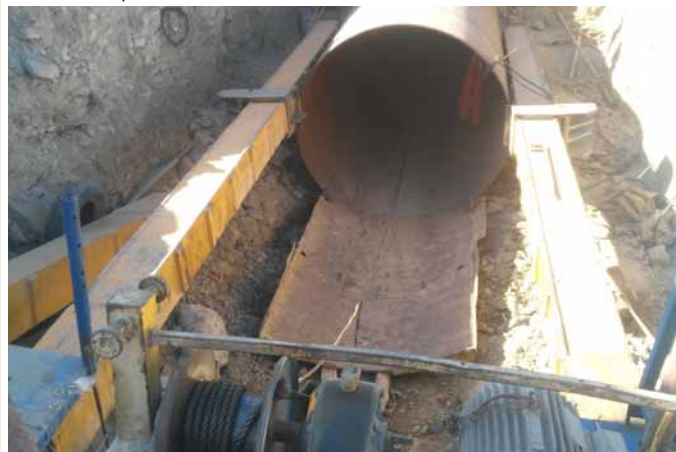
انجام عملیات پایپ جکینگ در محدوده پل پالایشگاه- 1400 Pipe Line- 00+300 KM
