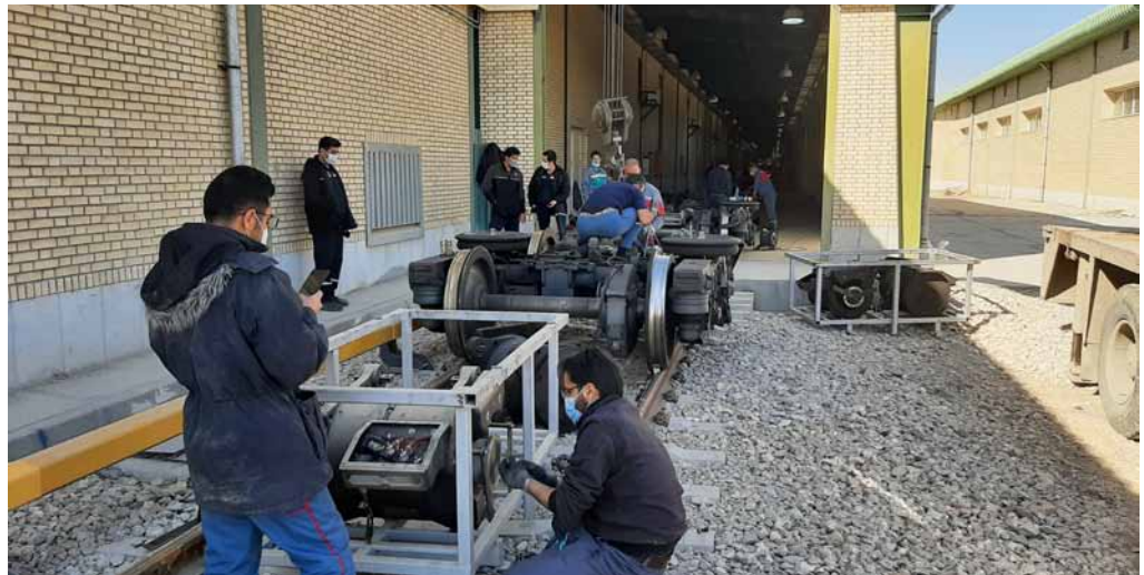
تعویض موتور ترکشن معیوب قطار ۲۰۴، تعمیر موتور ترکشن قطار ۲۰۶
