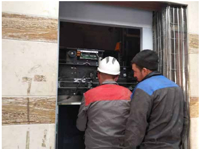
ایستگاه کمیل - وضعیت نصب آسانسور
