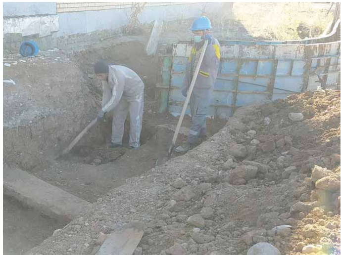
اجرای داکت بانك‌ها و نیز کانال‌هاي جمع‌آوری آب‌هاي سطحی
