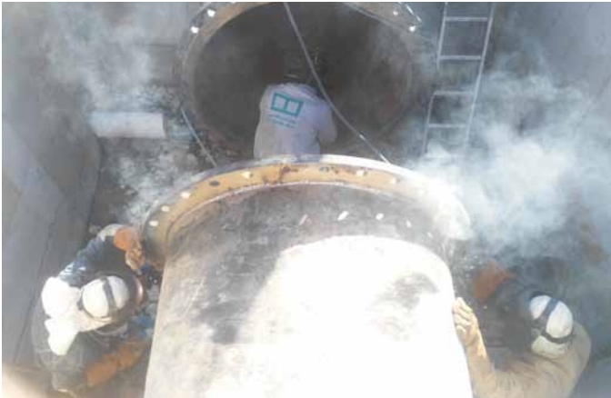
انجام عملیات مکانیکال حوضچه- 1200 Pipe Line- 22+975 KM
