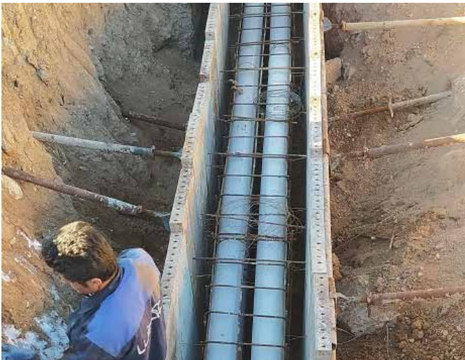
اجرای داکت بانك‌هاي الكتريكال و ابزار دقيق
