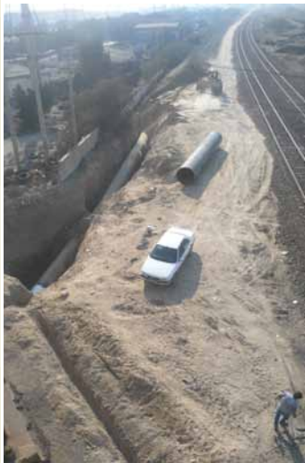
انجام عملیات بک فیل در ضلع غربی پل توسعه 1400 Pipe Line- 03+200 KM-
