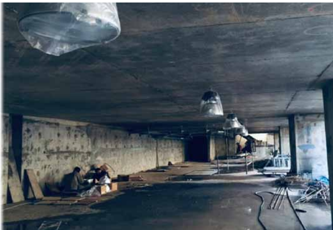
نصب روشنایی در طبقات نیروگاه
