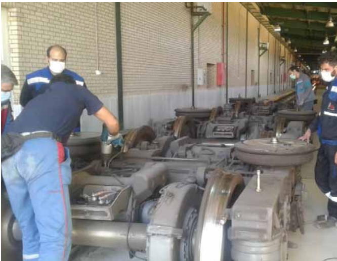
تعویض موتور ترکشن معیوب قطار ۲۰۴، تعمیر موتور ترکشن قطار ۲۰۶ (۵)
