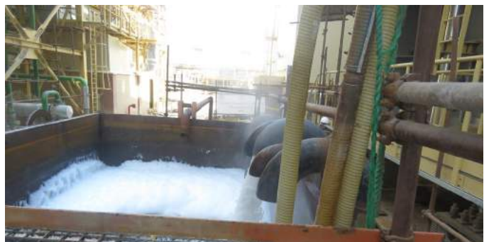
اسیدشویی بویلر شماره ۳
