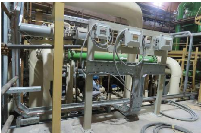
اجرای عملیات برق و ابزار دقیق در ساختمان CPP واحد شماره ۲
