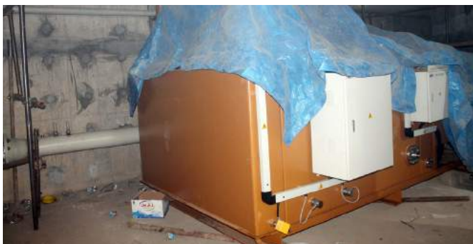
نصب تجهیزات گاورنر واحد اول
