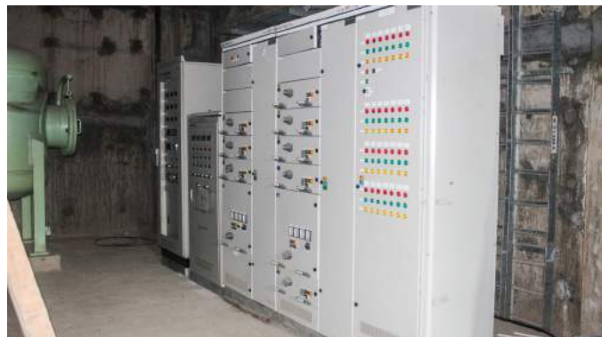
نصب پنل‌های اصلی
