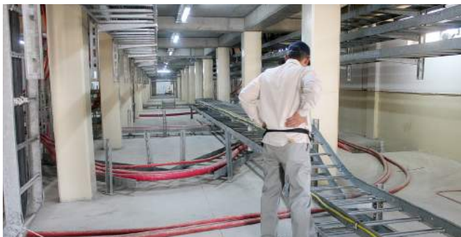
نصب ارت در پست الکتریکی
