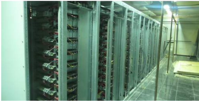
اجرای عملیات کانکشن تابلوهای مربوط به اتاق سوئیچ گیر واحد بخار شماره ۳
