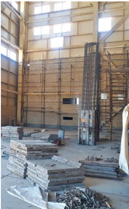
آرماتوربندی پلتفرم شماره ۱۳ سالن بخار
