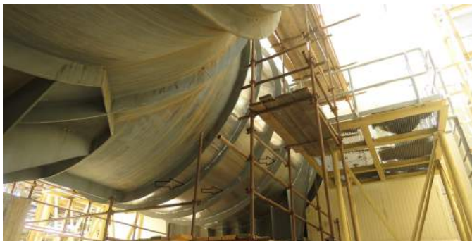
ماستیک کاری MAIN DUCT توربین هال واحد سوم
