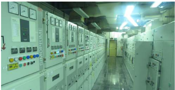
اجرای عملیات برق دار کردن تابلوهای مربوط به اتاق سوئیچ گیر واحد بخار شماره ۲
