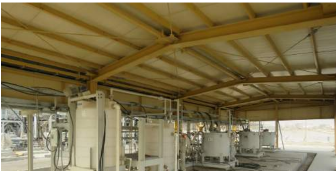
اجرای عملیات کابل کشی در ساختمان (Chemical Shelter) واحد آب شیرین کن
