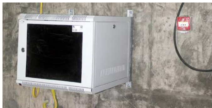
نصب سیستم تلفن و فایر آلام
