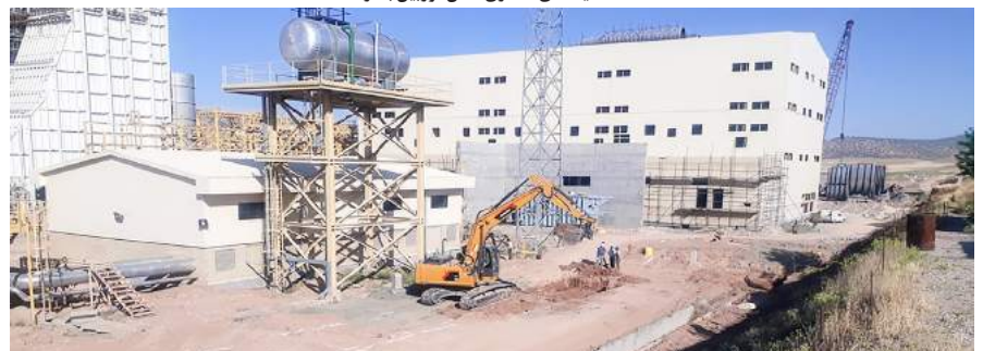
خاکبرداری روت شماره ۲ محوطه سایت
