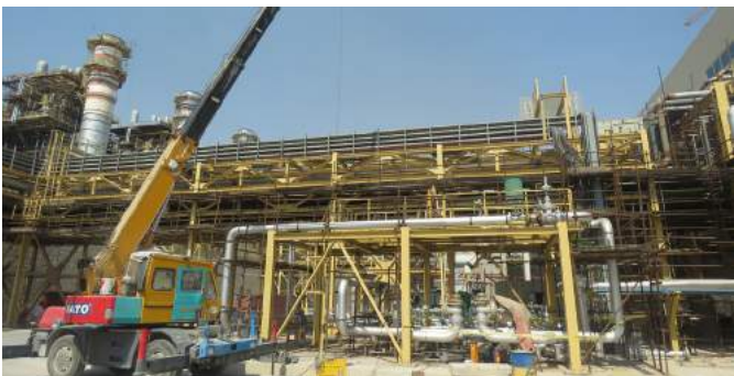
اجرای عملیات جوشکاری لوله‌ها در بلوک شماره ۳
