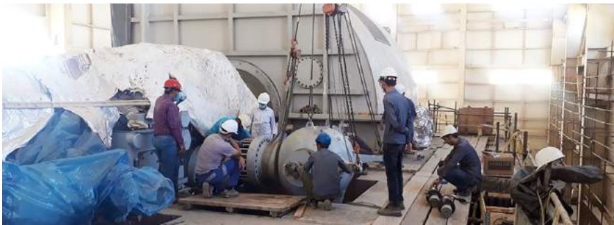
نصب ولوها و لوله‌های ورودی بخش فشار متوسط توربین بخار
