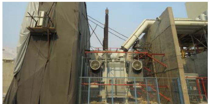
اجرای عملیات سرکابل زنی ترانس اصلی واحد بخار شماره ۱
