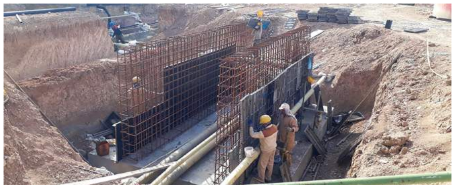
قالب‌بندی کالورت‌های محوطه سایت
