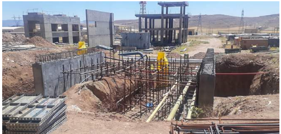
بتن‌ریزی کالورت‌های محوطه سایت
