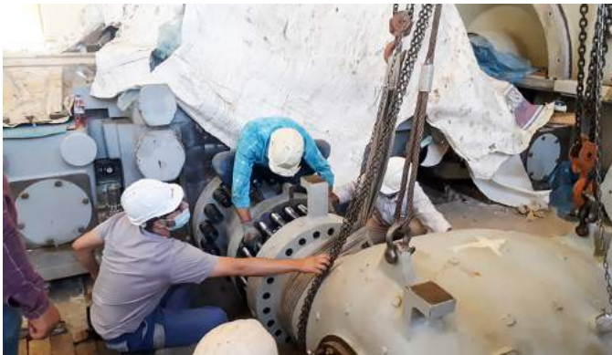
نصب ولوها و لوله‌های ورودی بخش فشار متوسط توربین بخار
