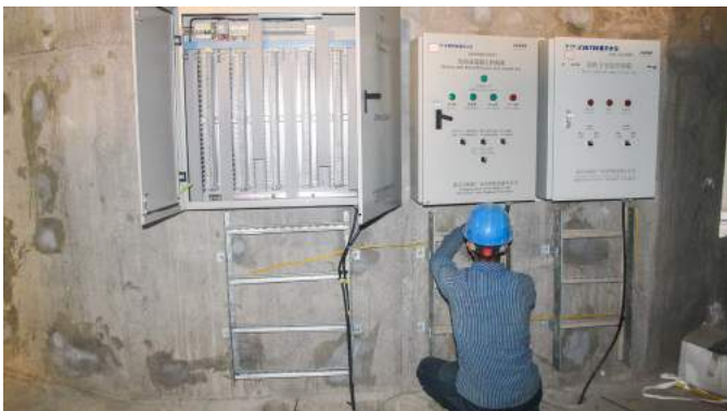
نصب و کابل کشی پنل‌های اصلی
