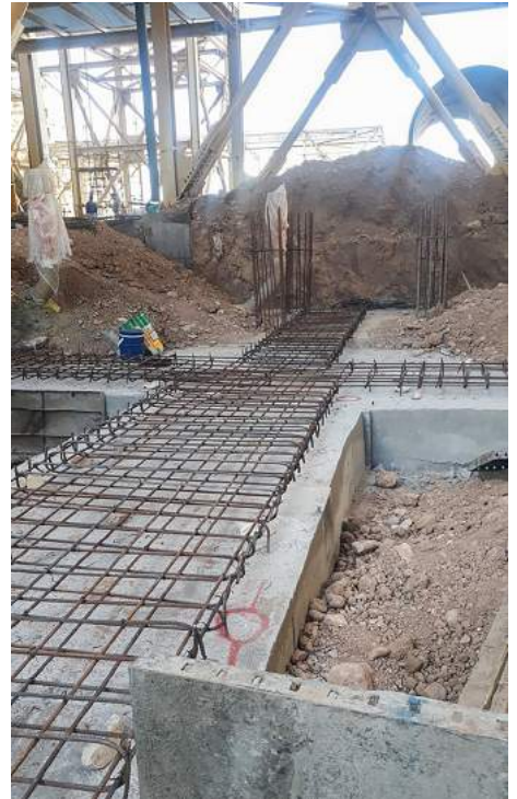
آرماتوربندی روت شماره ۲۳ محوطه سایت
