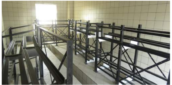
اجرای عملیات نصب رک های باتری در اتاق باتری واحد آب شیرین کن
