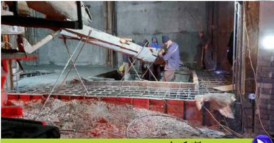
بتن ریزی پی اتاق کنترل
