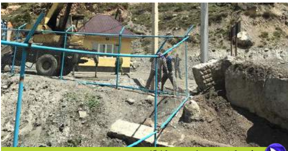
فنس کشی محوطه تجهیز کارگاه
