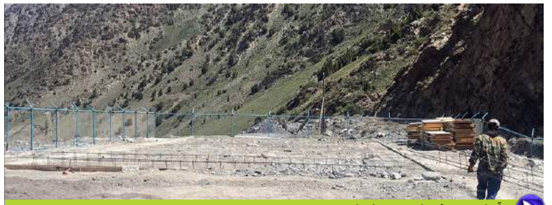
آرماتوربندی فونداسیون سوله ها
