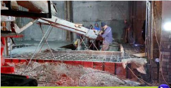
بتن‌ریزی پی اتاق کنترل
