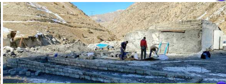
اجرای فونداسیون کانکس‌ها
