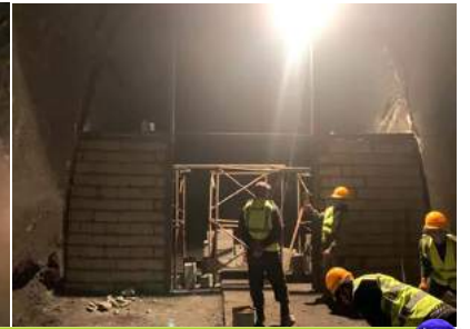
مسدودسازی Adit‌های بین تونل‌های ماشین‌رو و تهویه
