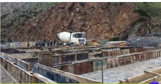
قالب‌بندی و بتن‌ریزی فونداسیون بلوک A3
