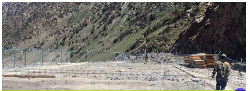
آرماتوربندی فونداسیون سوله‌ها
