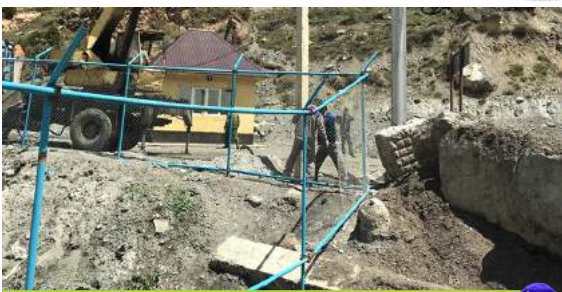
فنس‌کشی محوطه تجهیز کارگاه
