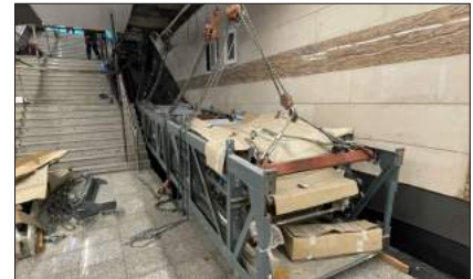
انجام عملیات جایگذاری پله برقی
