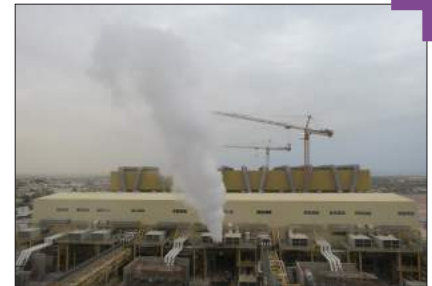
اجرای عملیات استیم بلو اوت مربوط به بویلر شماره ۳ از بلوک ۲
