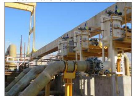
نصب فیلترهای آبگیر فاز ۱۵-۱۶
