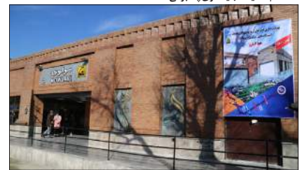
افتتاح ورودی شمالی ایستگاه مولوی
