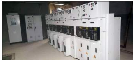
انتقال ۱۰ سلول از تابلوهای دی سی و ۲ عدد پالت چوبی از انبار مرکزی به تی بی اس ایستگاه
