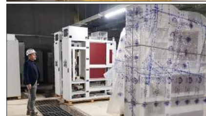
انتقال ۱۰ سلول از تابلوهای دی سی و ۲ عدد پالت چوبی از انبار مرکزی
