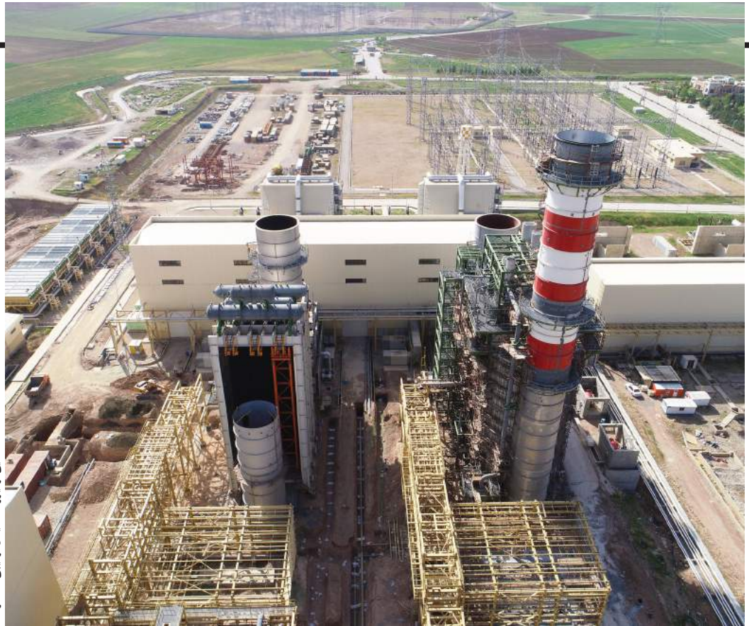
نمایی از نیروگاه سیکل ترکیبی دالاهو
