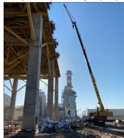
شروع عملیات اجرایی نصب تجهیزات موتور و گیربکس‌های سیستم خنک‌کن اصلی
