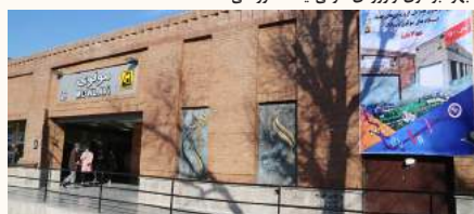
بهره‌برداری از ورودی شرقی ایستگاه رودکی
