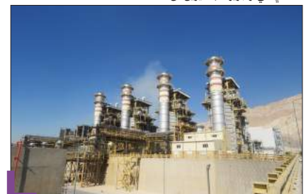
نمای کلی از بویلرها
