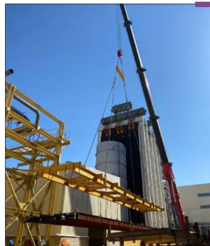
تسریع در عملیات اجرایی باقی‌مانده نصب هارپ‌های بویلر واحد ۱
