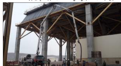
اجرای مسیرهای دسترسی کابل و داکت بانک‌های بین ساختمان‌های بخش بخار
