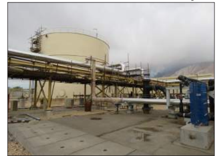
اجرای عملیات عایق و کلدینگ مربوط به لوله‌های جزیره آب شیرین‌کن
