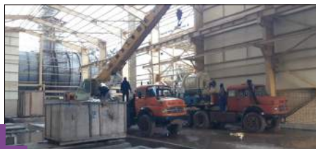
شروع نصب تجهیزات و پمپ‌های ساختمان CEP
