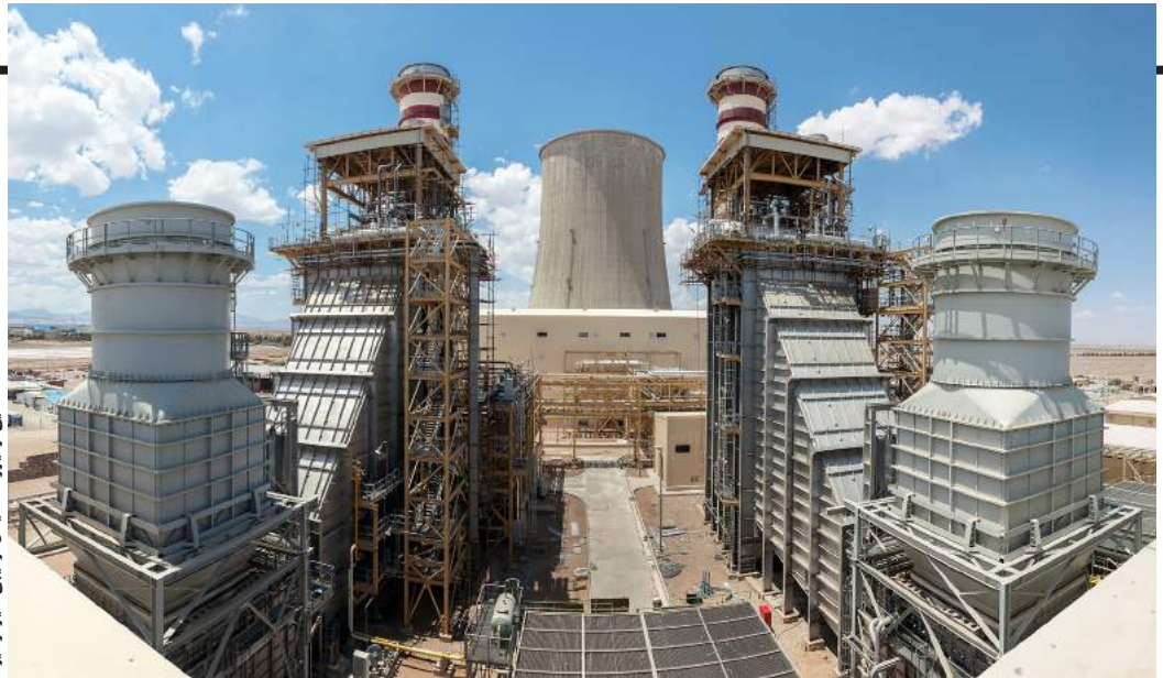
نمایی از نیروگاه سیکل ترکیبی شیرکوه بود
