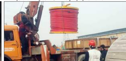
انتقال درام کابل بیست کیلوولت از انبار به ایستگاه
