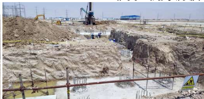
اتمام بگریزی و تخریب سرشمع‌های فونداسیون و توربین ژنراتور
