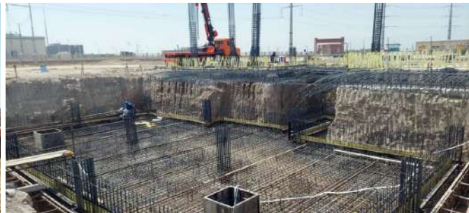
آزمایندگی در بخش گازی کابل ساختمان اتاق کنترل
