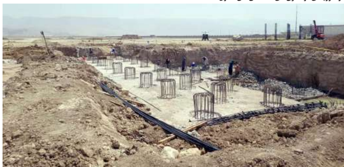
نمایی دیگر از اتمام بگریزی و تخریب سرشمع‌های فونداسیون و توربین ژنراتور
