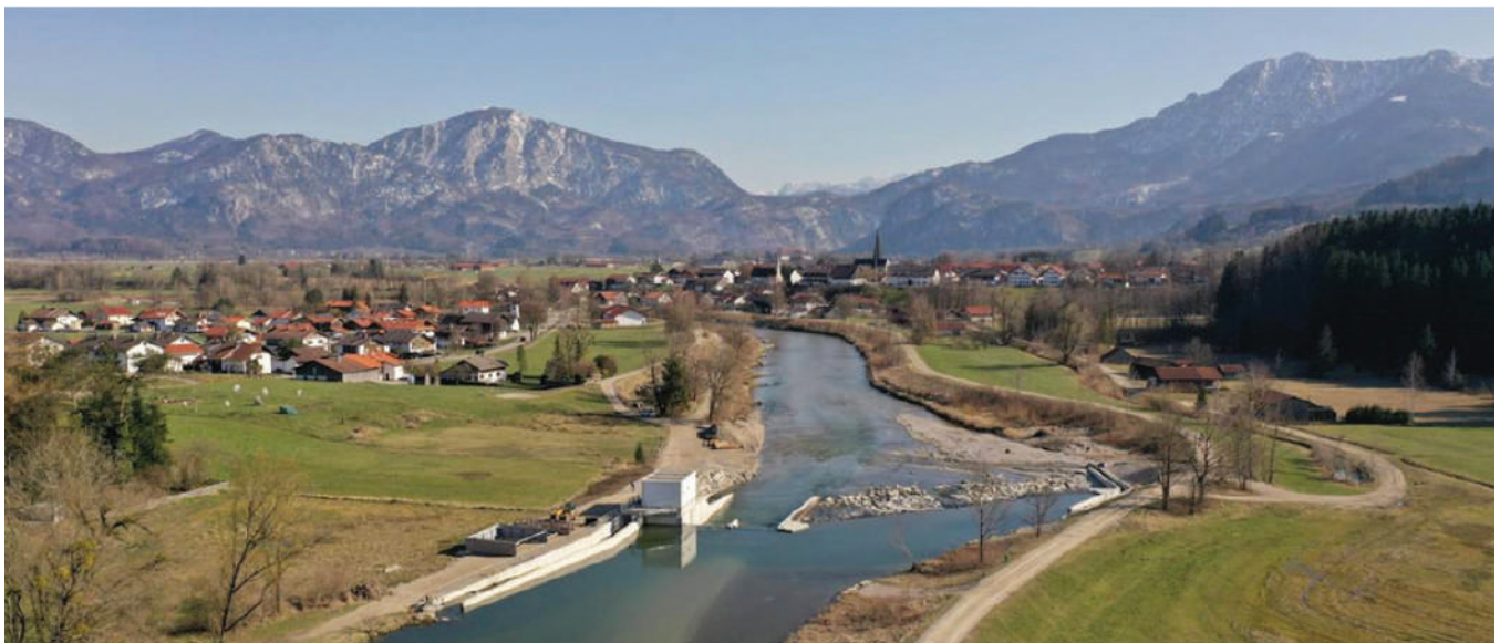
شکل ۴: نمای کلی رودخانه Loisach پس از ساخت نیروگاه
