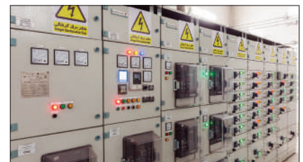
نصب تابلوهای L.V پست
