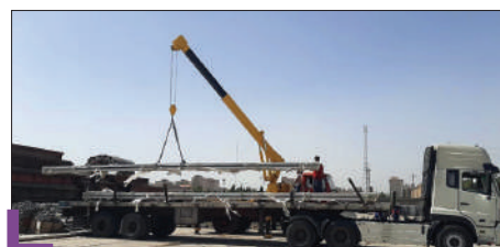
بارگیری و حمل شاخه‌های ریل سوم از انبار به محل نصب - خط ۷ مترو تهران
