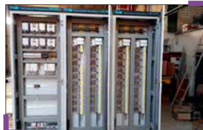
نمایی از ساخت تابلوهای کنترلی پروژه نیروگاه دالاهو
