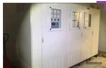
نصب تابلوهای یو بی اس سیگنالینگ و مخابرات ایستگاه
