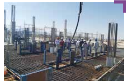
بتن ریزی سقف اول ساختمان CCB
