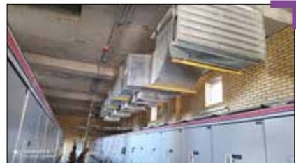
نصب کانال‌های HVAC
