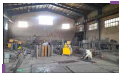
نمایی از ساخت قطعات مدفون فونداسیون نیروگاه
