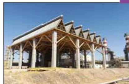
نمایی از عملیات نصب تیوب باندل‌ها و داکت بخار پروژه نیروگاه دالاهو
