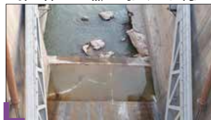
نمایی از دریچه‌های سد پروژه احداث سد درالوک ۲ عراق
