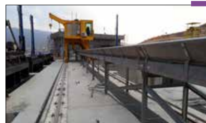
نمایی از عملیات نصب ماشین TRCM پروژه احداث سد درالوک ۲ عراق
