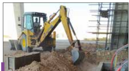
حفاری کانال برای اجرای ارت ACC
