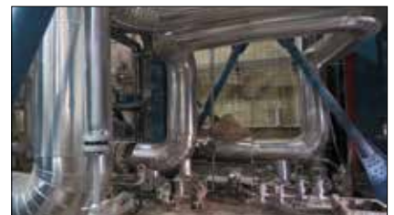
عایق کاری واحد دوم بخار
