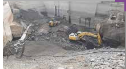
بتن ریزی سقف اول ساختمان CCB
