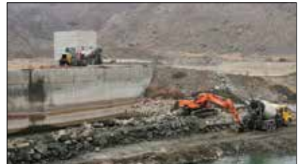
بتن ریزی بین سنگ‌های بولدر مسیر دایک
