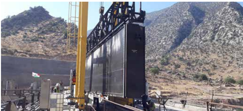
نصب دریچه‌های سد در الوک ۲ عراق
