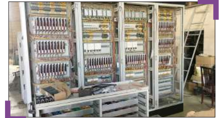
نمایی از ساخت تابلوهای کنترلی پروژه نیروگاه دالاهو
