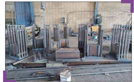
نمایی از ساخت قطعات مدفون پی نیروگاه
