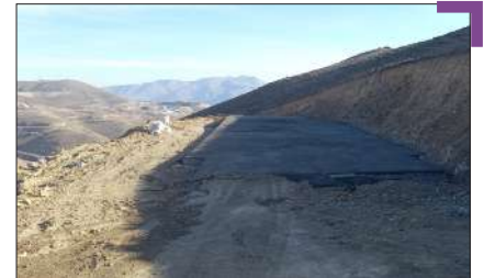
اجرای فونداسیون ساختمان اداری تجهیز کارگاه دائم
