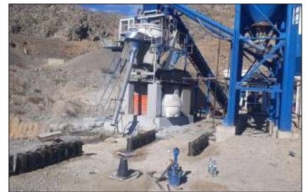
انجام تست‌های یکنواختی بتن
