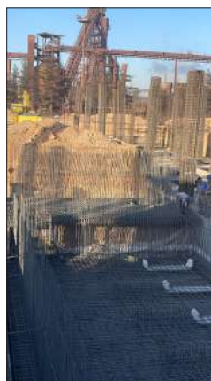
آرماتوربندی دیواره سامپ
