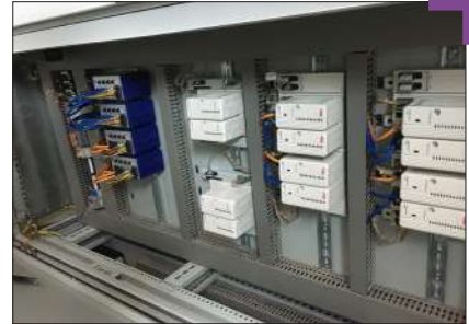
نمایی از ساخت تابلوهای کنترلی پروژه نیروگاه دالاهو
