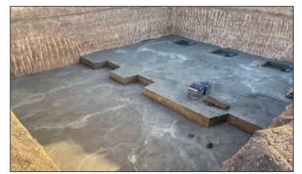
باز کردن قالب بتن مگر کلاریفاید
