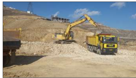
خاک برداری فونداسیون ساختمان اداری کارفرما
