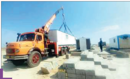
انتقال کانکس جهت تجهیز کارگاه
