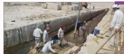
ادامه عملیات آرماتوربندی ترنج کابل
