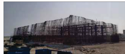
ادامه عملیات آرماتوربندی ساختمان تصفیه‌خانه
