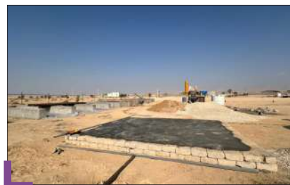
عملیات ساخت شاپ سندیلاست و سپول سازی - بستک
