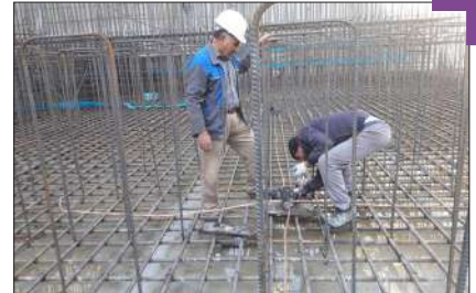
اجرای شبکه ارت در کف نیروگاه
