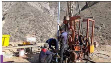
حفاری گمانه سدها و نمونه برداری ۲
