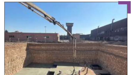
اجرای بتن مگر فونداسیون کلاریفاید
