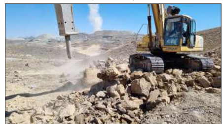
حفاری زمین سنگی با پیکور-ZONE5
