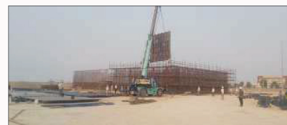
ادامه عملیات قالب‌بندی دیوار تصفیه‌خانه
