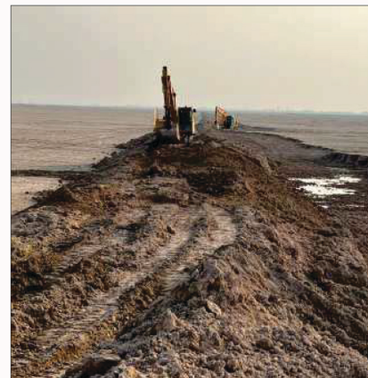
احداث دایک پیرامون سایت
