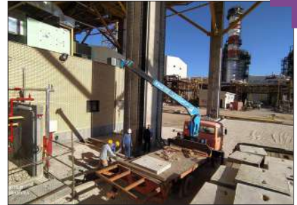
نصب درپوش های کانال جنوب (NXPowerLite) ACC SWGR
