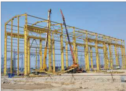
ادامه عملیات نصب استراکچر ساختمان توربین‌ها
