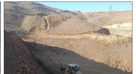
خاک برداری مسیر کانال های جنوبی ۲
