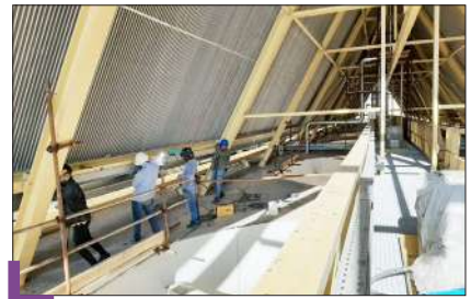
جوش نبشی ها به سیلینگ های بالای ACC
