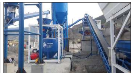
نصب و راه‌اندازی تجهیزات افزودنی بچینگ
