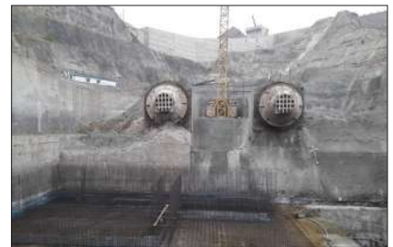
عملیات آرماتوربندی واحدهای نیروگاه
