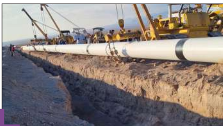
عملیات لوله گذاری داخل کانال
