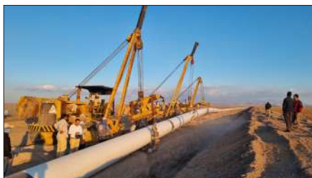
عملیات لوله گذاری داخل کانال
